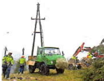
200 Kelag-Monteure sind in ganz Kärnten im Einsatz KK/KELAG
