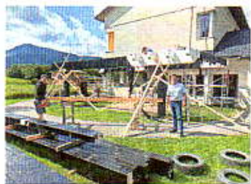
Ronny Rull bei der Besichtigung der Baustelle
